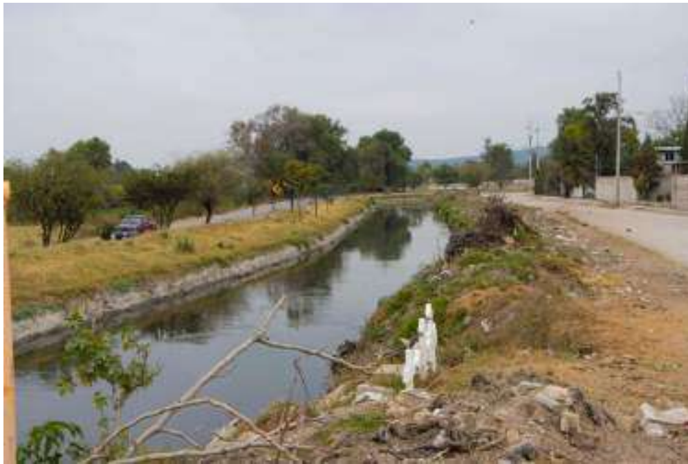
Imagen 4 Río donde desembocan líneas de aguas negras
